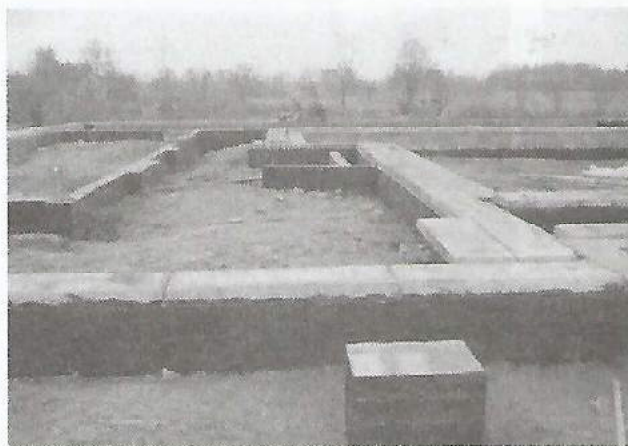
Solidne ławy fundamentowe już są...
