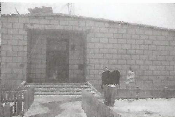
fot. 2 Jakies deski na dachu, zwilgotniałe ściany, ślady dymu sugerują, że coś się stało.
